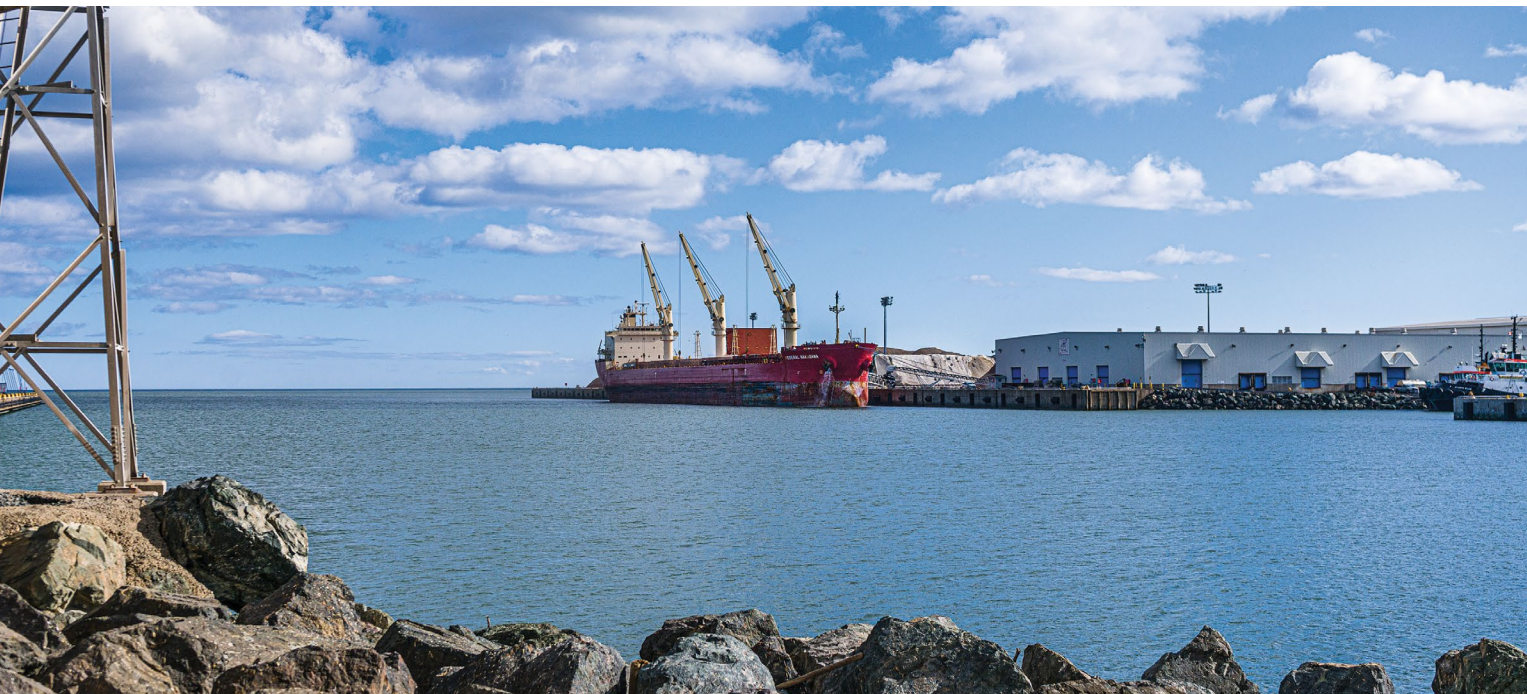
Port of Belledune (Belledune, NB)
